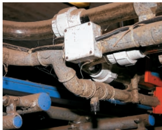
Zu viele und scharfe Schikanen in der Melkleitung schädigen die Milch und führen zu Vakuumverlusten.
