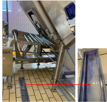
Abflussrinne: Nach dem Entfärber
