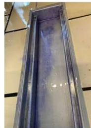
Abflussrinne unterhalb Slicer Abflussrinne mit einem Biofilm
