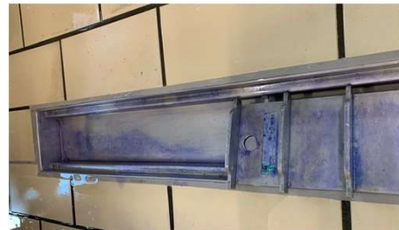
Abflussrinne unterhalb Slicer Abflussrinne mit einem Biofilm
